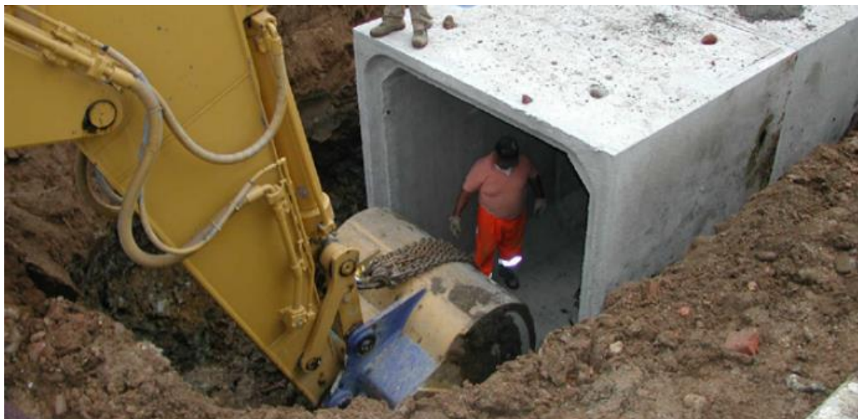
Figura 4-37: Execução de supertubo na região da Lombardia, Itália (ABCP, 2016)
